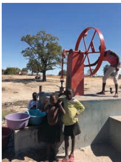
FOTOGRAFIA 4.6. Furo com bomba Volanta perto de Onjiva (à esquerda); furo equipado com bomba solar e reservatório de armazenamento em Omambodi, comuna de Mongua (à direita)
