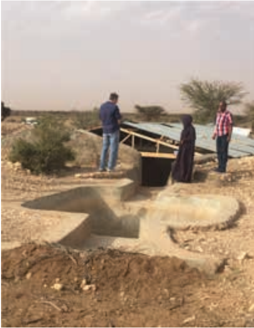
FOTOGRAFIA 4.12. Armadilha de sedimentos que protege a cisterna (“berkat”) na Somalilândia (duas imagens à esquerda) e armadilha de sedimentos com filtro de areia para duas cisternas diferentes em Djibuti (duas imagens à direita)
