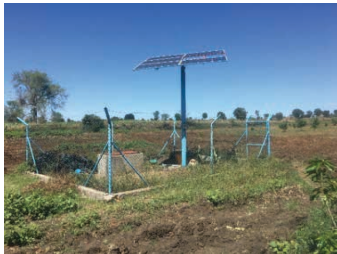
FOTOGRAFIA 3.1. Bomba Volanta (à esquerda); um ponto de água alimentado com energia solar (à direita)
