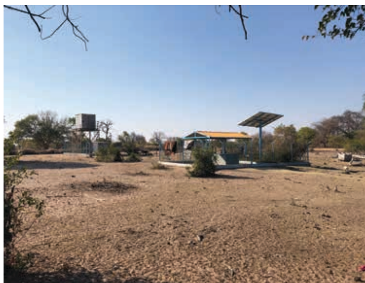
FOTOGRAFIA 4.6. Furo com bomba Volanta perto de Onjiva (à esquerda); furo equipado com bomba solar e reservatório de armazenamento em Omambodi, comuna de Mongua (à direita)
